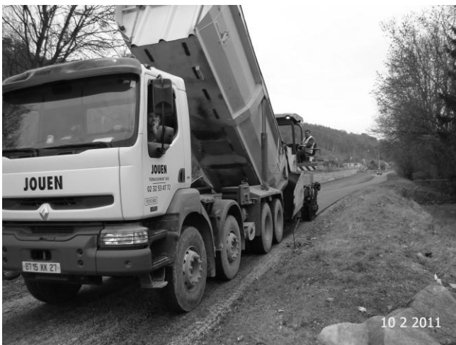
10 Février 2011 : Un camion d'enrobé (granulats, bitume, sable) vient d'arriver tout chaud de Gaillon et décharge dans le « finisher »
