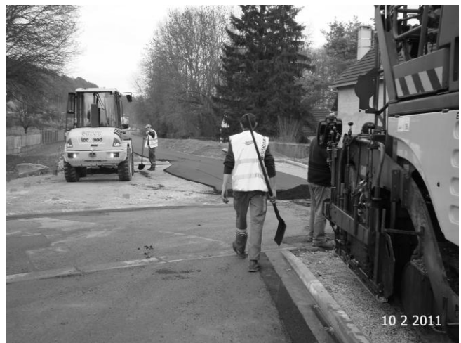
10 Février 2011 : On termine à la main quand on franchit une voie routière
