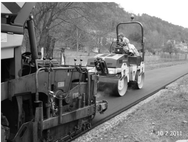
10 Février 2011 : Le « finisher » en action. Derrière on compacte pendant que c'est chaud
