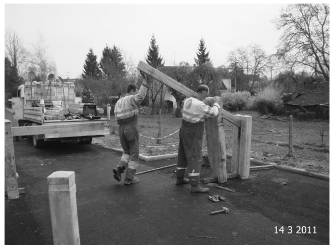
14 Mars 2011 : La Signalisation Routière d'Évreux pose des barrières en bois de Normandie (chêne de pays non traité) à chaque sas de sécurité
